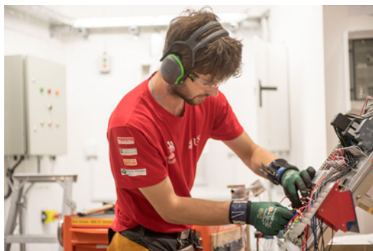
Beat Schranz durante il cablaggio di componenti
