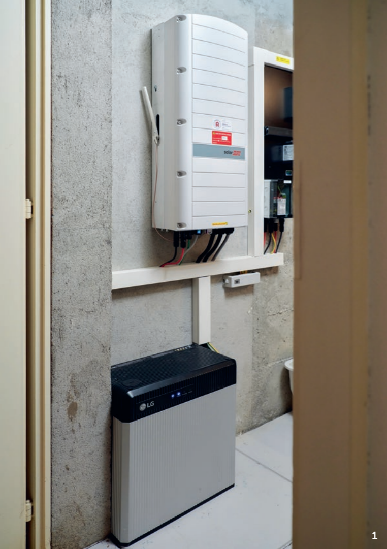
1 Solarwechselrichter, Speicherbatterie und ... 2 Ladestationen für Elektrofahrzeuge gehören zum neuen Geschäftsmodell. 3 Olivier Maillard, umgeben von Marc (links) und Yves Amaudruz, schätzt die umgesetzten technischen Lösungen.
